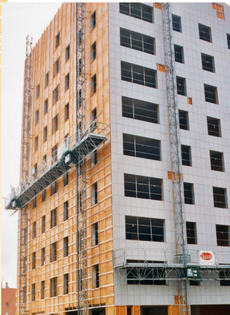
Fachada ventilada proyectada con espuma de poliuretano.
