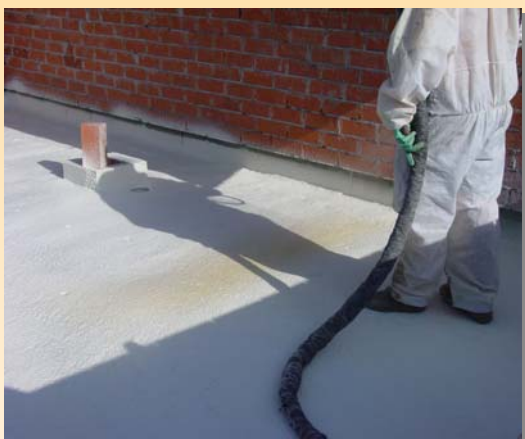
Cubierta transitable proyectada con espuma de poliuretano
