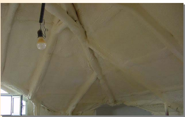
Con el poliuretano proyectado se eliminan fácilmente los puentes térmicos, independientemente de su complejidad
