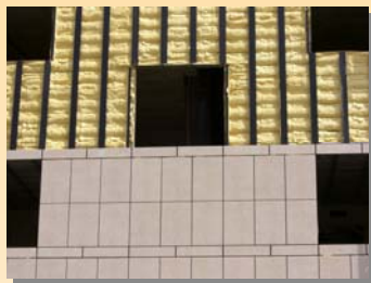
Impermeabilidad y ausencia de puentes térmicos
