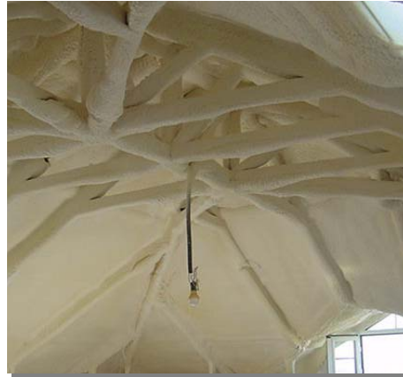
El poliuretano proyectado tiene una gran adherencia y adaptabilidad al sustrato.
