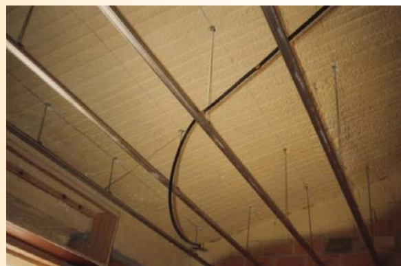
Es importante no dañar la espuma al colocar los soportes del techo.
