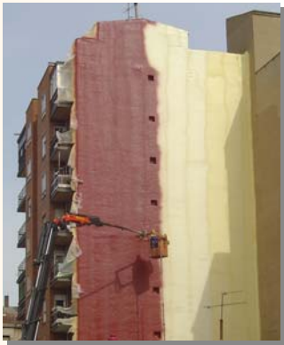
Proyección en medianera con protección
