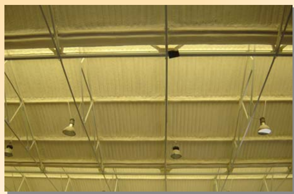
Cubierta de chapa aislada con poliuretano
