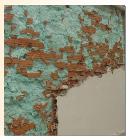
La espuma expande en el interior de la cámara, rellenando el espacio entre las dos hojas
